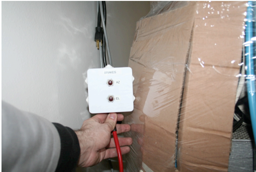
Figura 7: “BRAKES” manual, comando manual para desactivar los frenos del radiotelescopio
