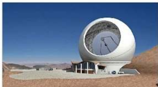
El Cerro Chajnantor Atacama Telescope (CCAT) es una única antena radiotelescópica de 25 metros de diámetro dentro de una cúpula protectora. La construye un consorcio de universidades de Norteamérica y Europa. Será un complemento de ALMA, que está en las cercanías.
