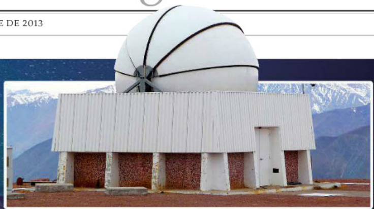
La cúpula del CATA 500 en cerro Tololo está hecha con fibra de vidrio y un esqueleto de metal articulado. Fue diseñada en el Departamento de Ingeniería Mecánica de la Facultad de Ciencias Físicas y Matemáticas de la U. de Chile.
